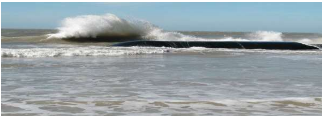
ნახ. 3.2. სანაპირო ზოლზე ACE Tube განლაგება
